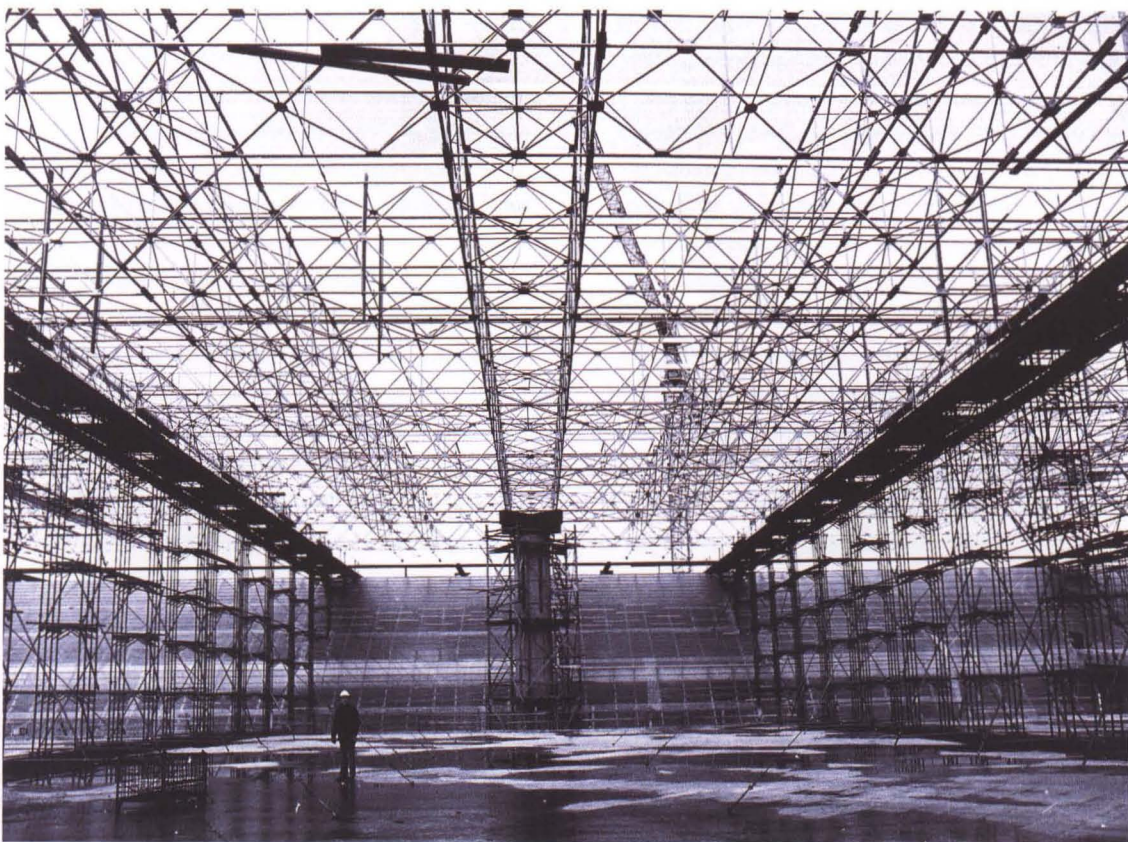
Stålkonstruktioner fik øget betydning for den praktiske forskning ved Laboratoriet for Bygningsteknik i 1970'erne. Det gjaldt gittermaster og ikke mindst tagkonstruktioner i flyhangarer, haller, koncertsale og indkøbscentre som her City 2 i Taastrup, der åbnede i 1975 og havde et tagareal på 100.000 m 2 . (Foto: Gengivet med tilladelse fra Rambøll Gruppen A/S).
