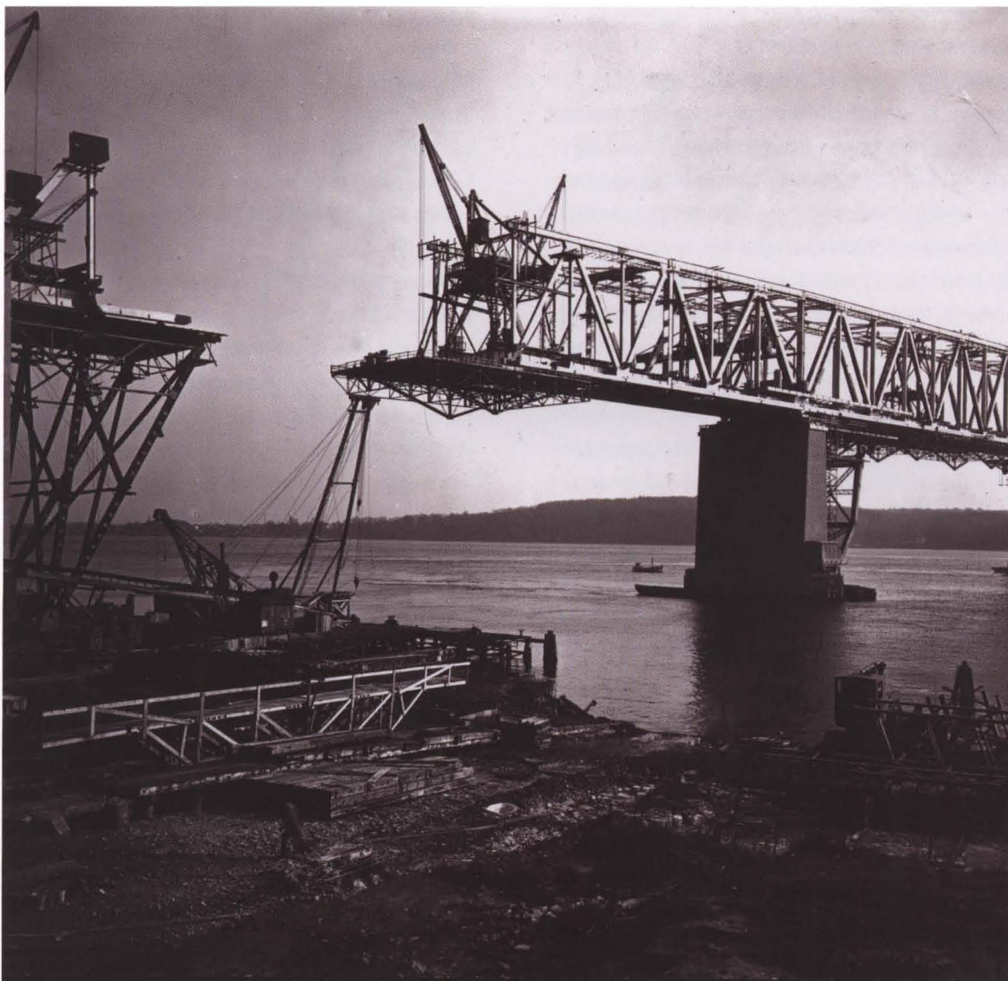
Den gamle Lillebæltsbro. Et lokomotiv med vogne udøver en tryk- og stødbelastning på underlaget, der ikke tåler sammenligning inden for landtransport. Jernbanebroer og viadukter blev således en særlig drivkraft og udfordring i den bygningstekniske udvikling. Med 35 meter er bropillerne, der bærer den første Lillebæltsbro bygget 1933 - 35 med Anker Engelund som konstruktør, den dag i dag de dybest funderede i Danmark (Foto: Gengivet med tilladelse fra POLFOTO).
