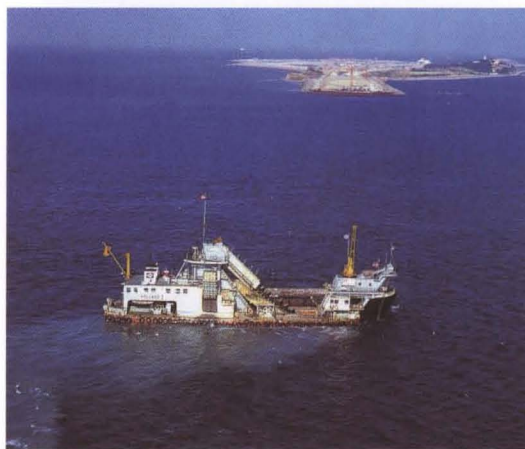
Kompensationsudgravning i forbindelse med bygningen af Øresundsforbindelsen (Foto: Gengivet med tilladelse fra Sund & Bælt)
